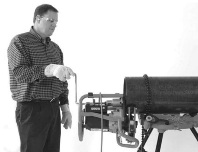
Obrázek 15B – Provádění ukosení
