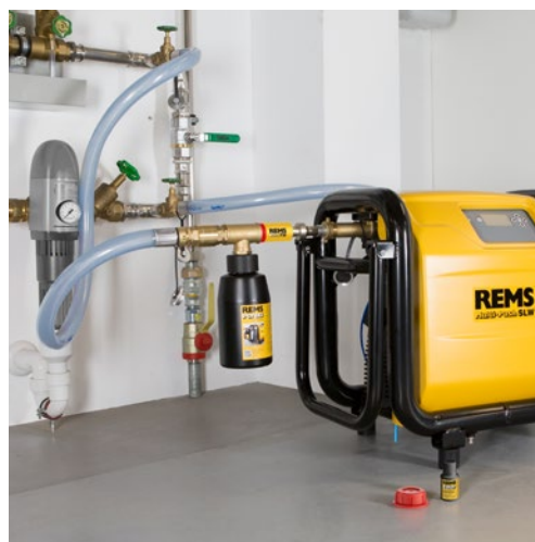
Dezinfekce rozvodů pitné vody
